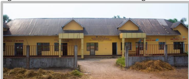
Figure 14 : Bâtiment administratif d'Inongo
