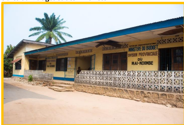
Figure 16 : Bâtiment abritant les Divisions provinciales du Budget et des Finances
