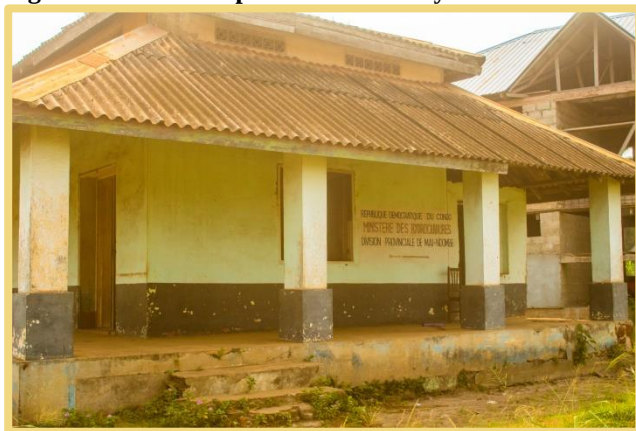
Figure 20 : Division provinciale des Hydrocarbures
