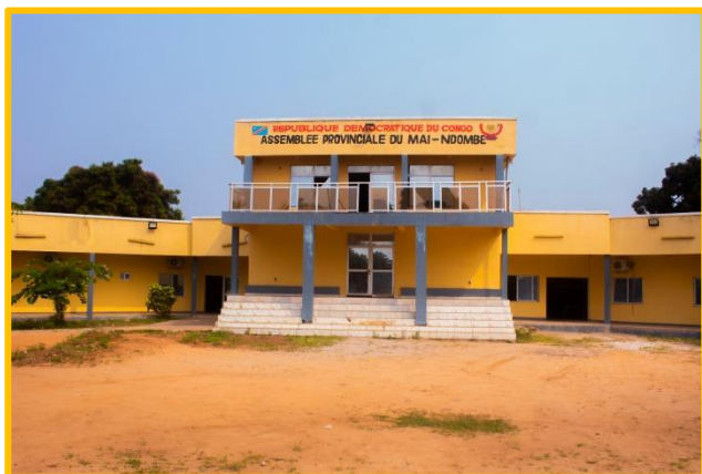
Figure 9 : Vue du Bâtiment de l'Assemblée provinciale du Mai-Ndombe
