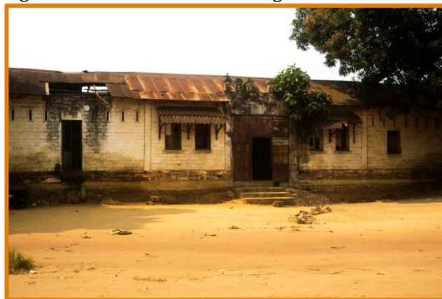
Figure 13 : Prison centrale d'Inongo
